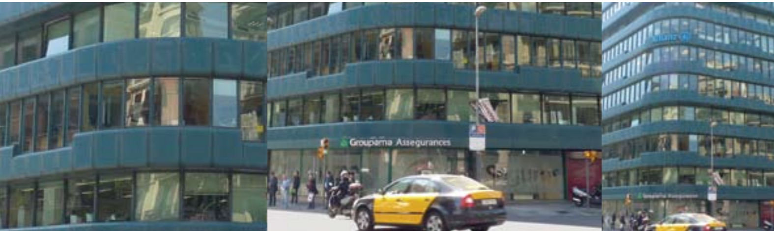
Edificio de Balmes 7 de Barcelona que acoge, en su primer piso, las oficinas de la Taula del Tercer Sector y del Observatori del Tercer Sector.
